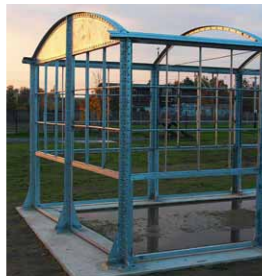
Teil des ehemaligen Personentunnels, heute Unterstand im Bürgerbahnhof Plagwitz. Fotos (2): Heinker
