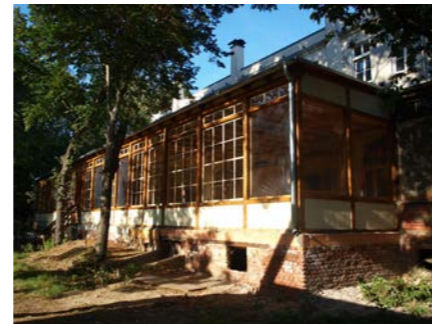
September 2012: Die Verglasung hat begonnen.
