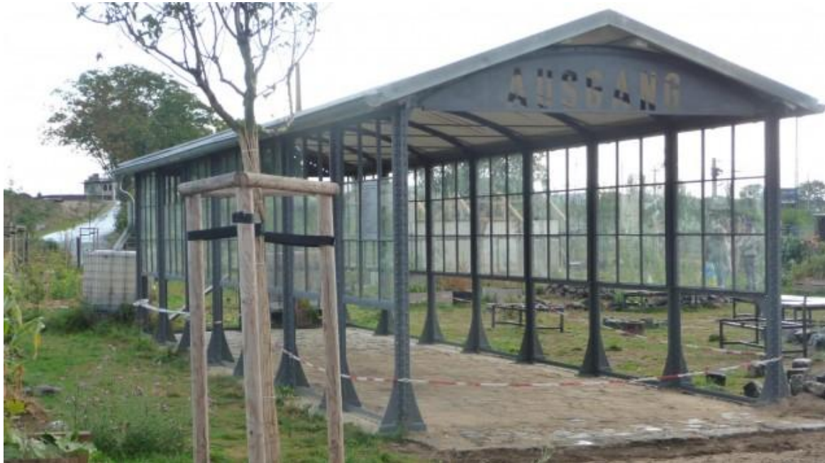
Überdachungen der ehemaligen Gleisaufgänge im Plagwitzer Industriebahnhof (Karoline Knappe)
