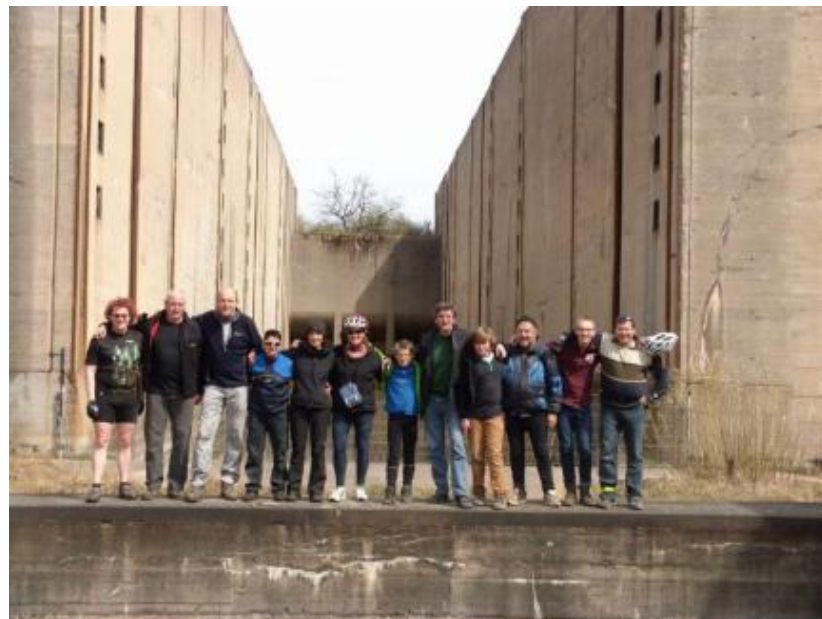
Die Crew von der Schleuse in Wüsteneutzsch
