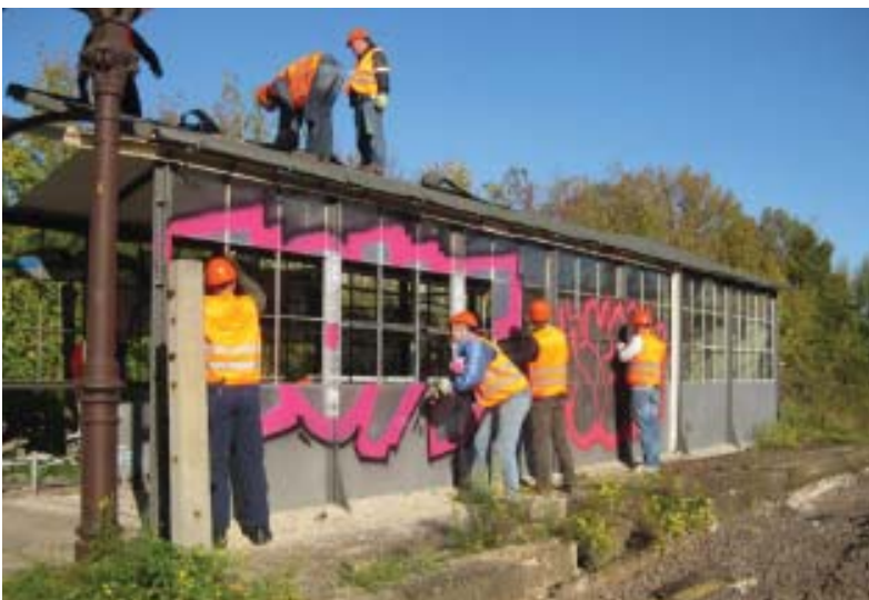
Sicherung von Relikten aus der Bahnhofsgeschichte zur Wiedernutzung (Initiative Bürgerbahnhof Plagwitz)
